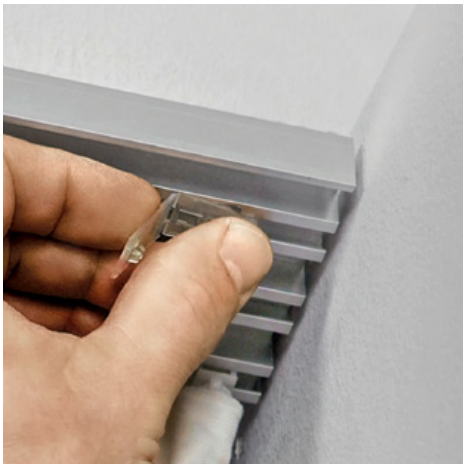
'CLIC STOP als Endfeststeller oder als Zwischenfeststeller in die Schiene klicken ...
